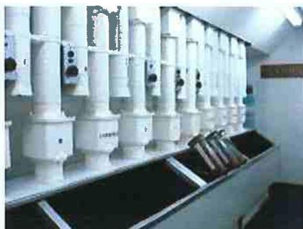
Fig. 22 – Estação central do sistema de correio pneumático do Cenesp
